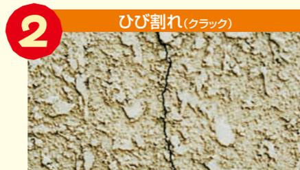
素材まで達したようなひび割れのひどいものは、放置しちゃダメ! 裂け目から雨水が入って壁の中を傷めてしまうことになるよ! しっかりチェックしよう!
