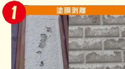
このまま塗膜剥離を放置すると、素材自体の劣化に進行するので、その前に周辺を含め劣化塗膜を除去してから塗装することが重要だよ!
