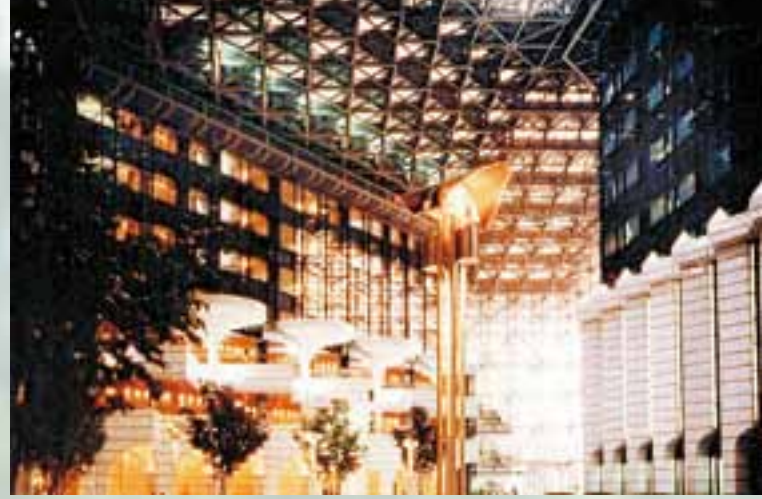
耐火塗料施工写真 [大森ベルポートⅡ期工事]
