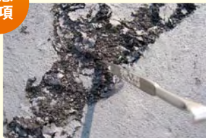
簡易アスファルト(小規模施工や補修に用いる、常温で施工できる簡易材料(常温合材))は、熱により軟化してしまうため塗装できません。
